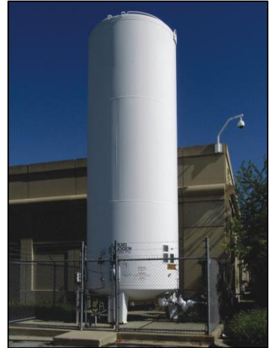
خزانات تبريد للعزل (مطلوب تودو بيرلايت خاص من الدرجة 45)
