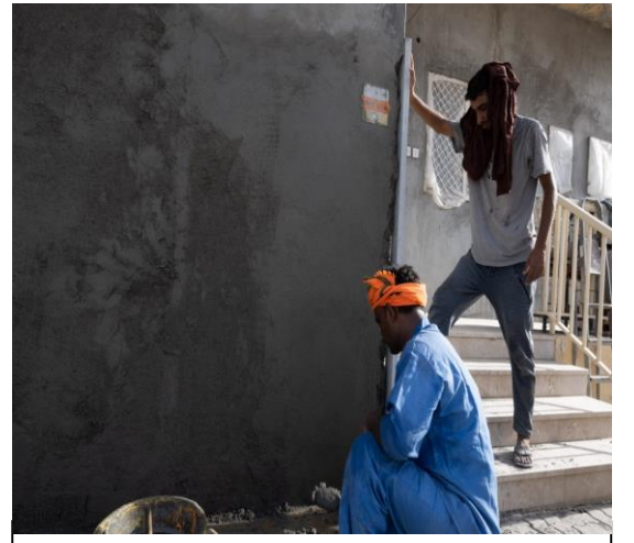
لياسة عزل حراري داخلي وخارجي
