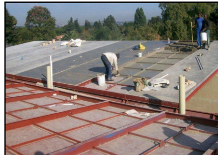
اسطح اسقف معزولة حرارياً
