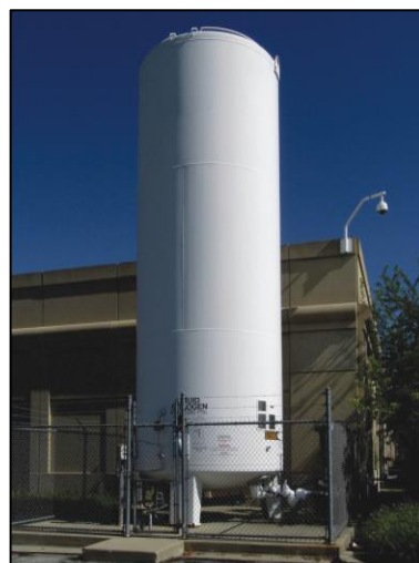
خزانات تبريد للعزل (مطلوب تودو بيرلايت خاص من الدرجة 45)
